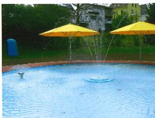
Projektbeispiel: Freibad in Riegelsberg
