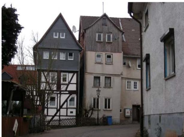
Abbildung 63: Fachwerkhäuser in Sachfachwerk und teilweise Behang und verputztes Fachwerk im Stadtkern, Laubach
