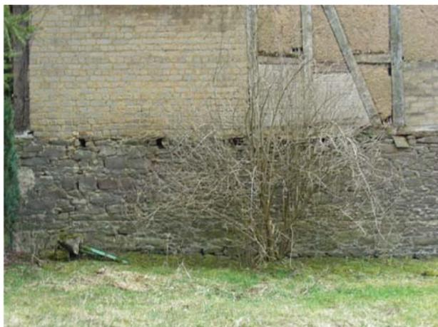
Abbildung 55: Fachwerkhaus mit Basaltsockel und Mischkonstruktion, Gontherskirchen
